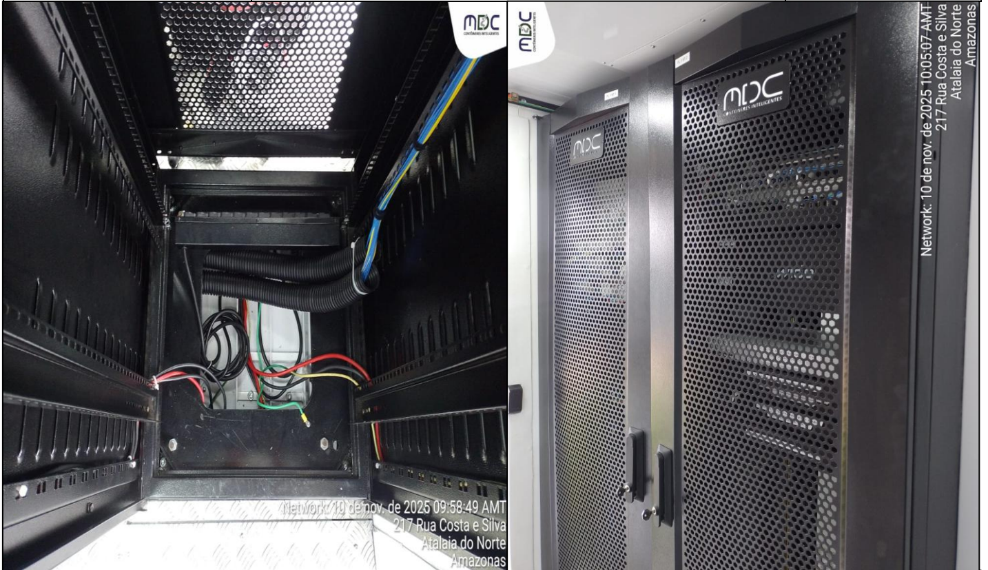
Limpeza dos Rack's.
