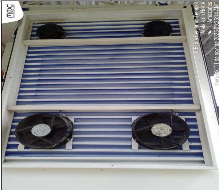
Condição inicial dos ventiladores, apresentando acúmulo significativo de sujeira antes do processo de limpeza, comprometendo a eficiência do sistema de exaustão dos equipamentos.
