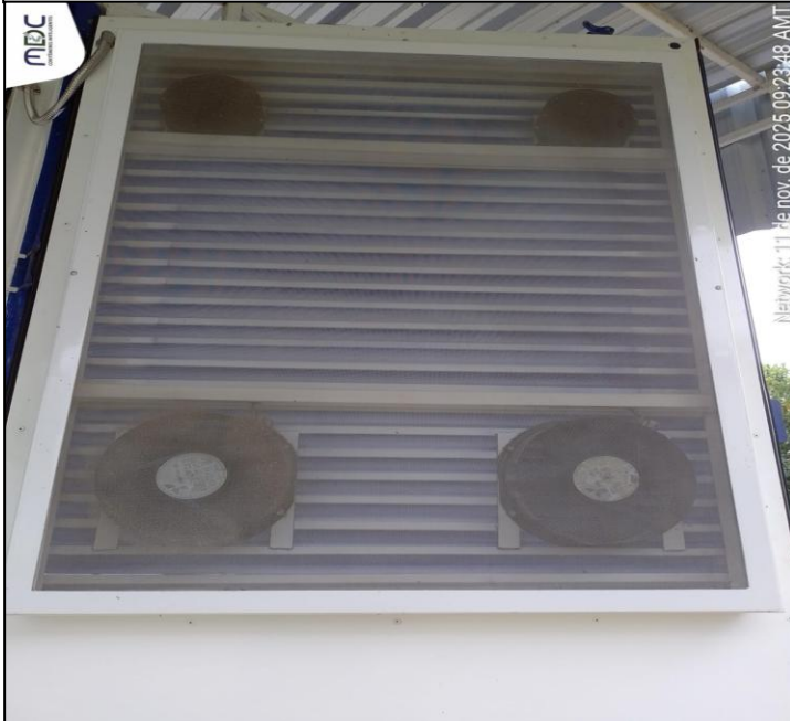
Condição inicial dos filtros, apresentando acúmulo significativo de sujeira antes do processo de limpeza.
